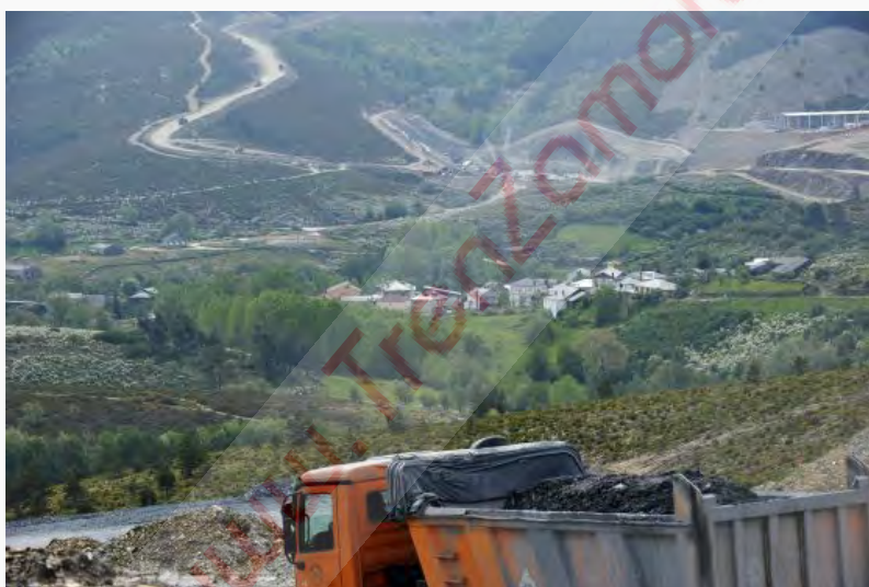
Obras del AVE. / NACHO GÓMEZ
