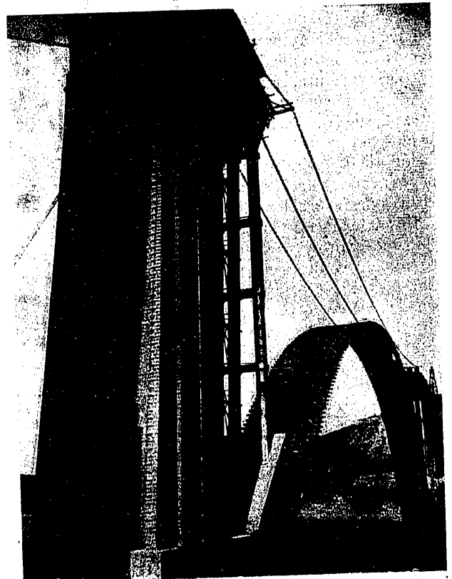
Pasarela y comienzo de la construcción de la cimbra.
