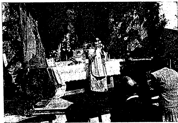
Misa celebrada al terminar el montaje de la estructura metálica, en acción de gracias por no haber ocurrido ningún accidente grave.
