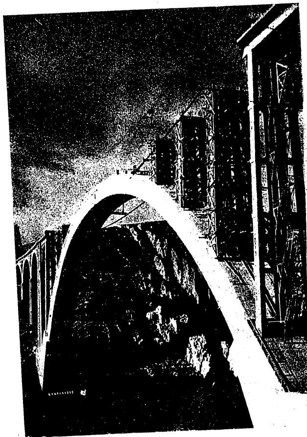
Construcción de los tímpanos.
