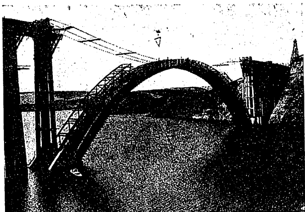
Transporte de un elemento triangular de la estructura metálica.
