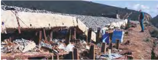
Antiguos refuerzos en la vía que el deslizamiento de tierra ha dejado al descubierto en Carbajales de Alba Foto David Rodríguez
