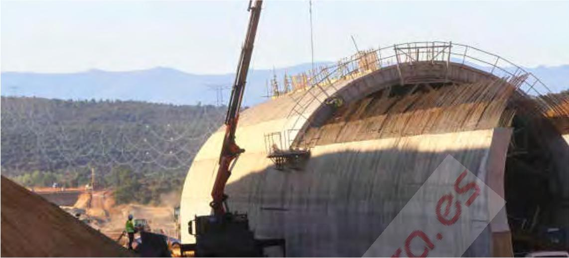
*Construcción de uno de los falsos túneles entre Tábara y Otero de Bodas. Las estructuras se volverán a cubrir con tierra y permitirán el paso de la fauna y un menor impacto ambiental.*
