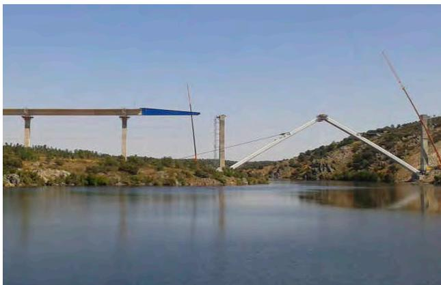
*Puentes sobre el embalse del Esla, de 368 metros (izquierda) y sobre el de Agavanzal (derecha), de 700 metros (cada uno de los brazos metálicos inclinados mide 80 metros).*
